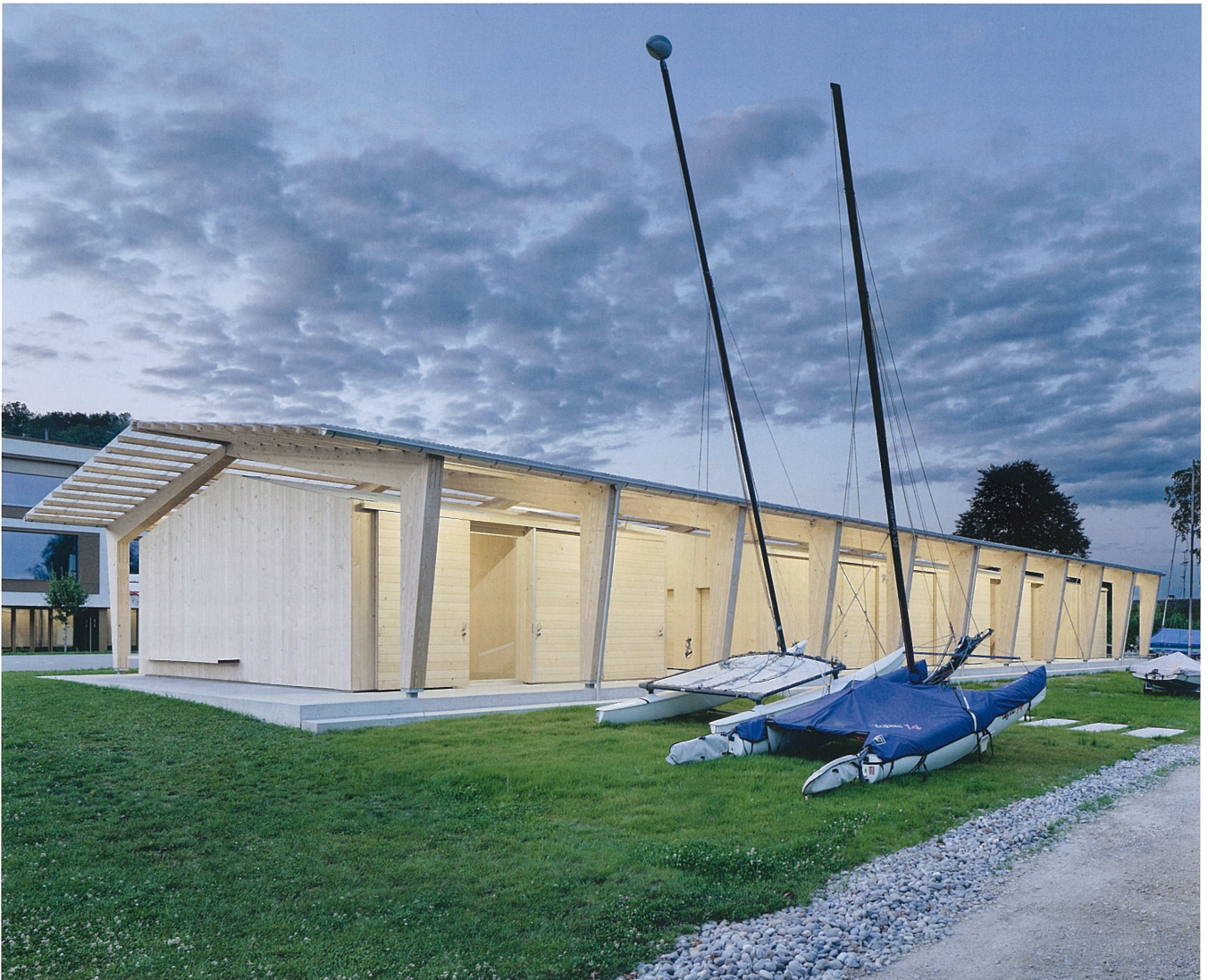
Das neue Wassersportzentrum in Nant wirkt leicht und durchlässig: Die Tragstruktur aus Holz trägt das Dach, unter dem drei freistehende Körper mit unterschiedlichen Nutzungen versammelt sind. Architektur: Atelier Pulver Architectes SA, Sugiez. Foto: Thomas Telley, St. Antoni
